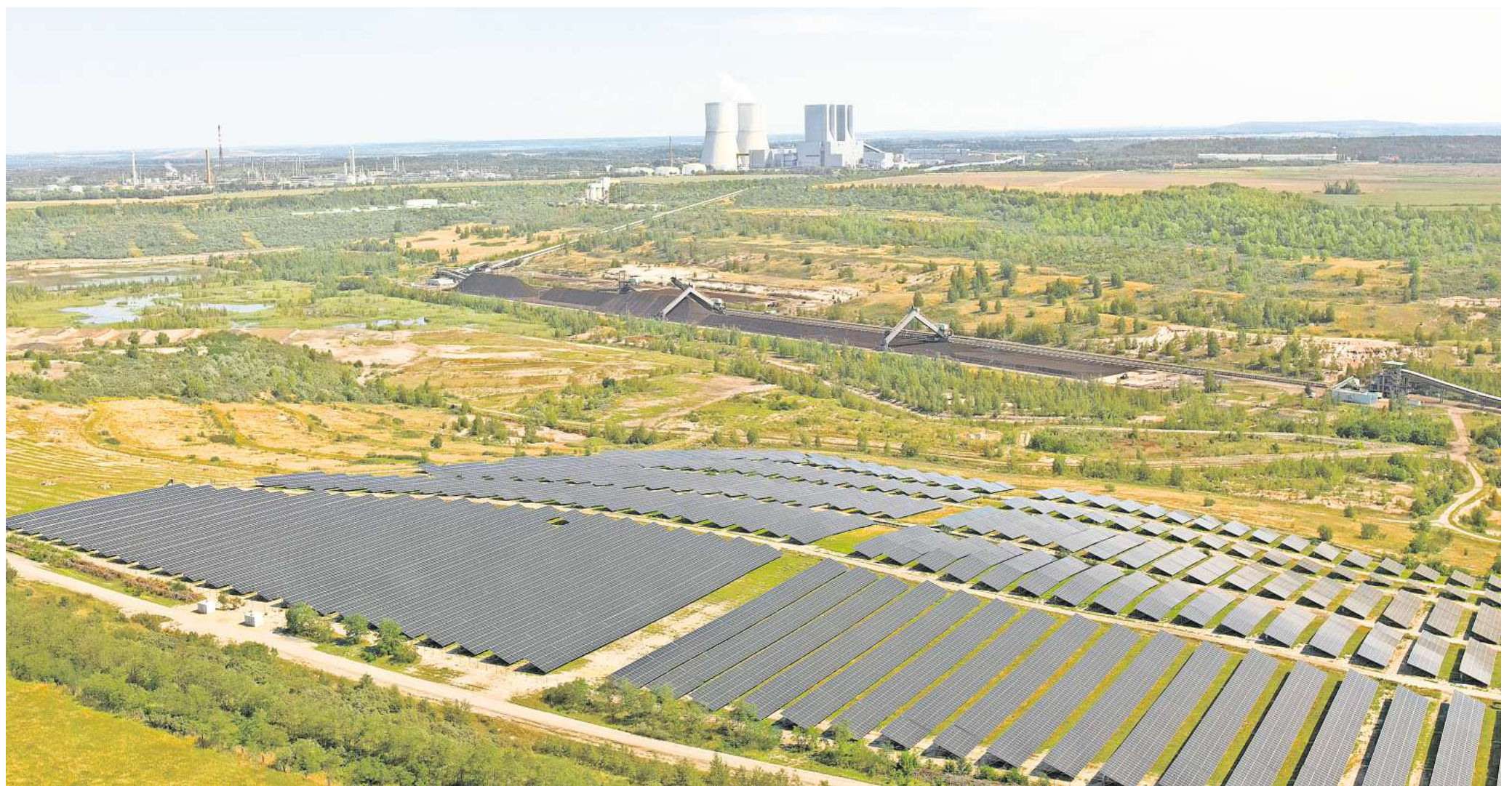
Einen riesigen Solarpark hat das Braunkohleunternehmen Mibrag im Tagebau Vereinigtes Schleenhain südlich von Leipzig in Betrieb genommen. Die Anlage Peres II befindet sich im Uferbereich des künftigen Pereser Sees und ist 77 Fußballfelder groß. FOTO: MIBRAG
